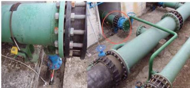
Figura 3. Instalação de um “datalogger” na conduta de ligação ao RAC.
